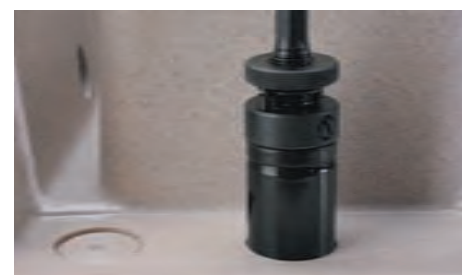
Fig. C - Procedere con il completamento del foro
