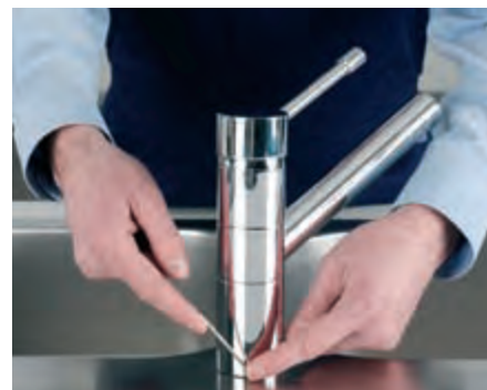
Fissare il rubinetto alla base utilizzando la seconda chiave esagonale in dotazione.
